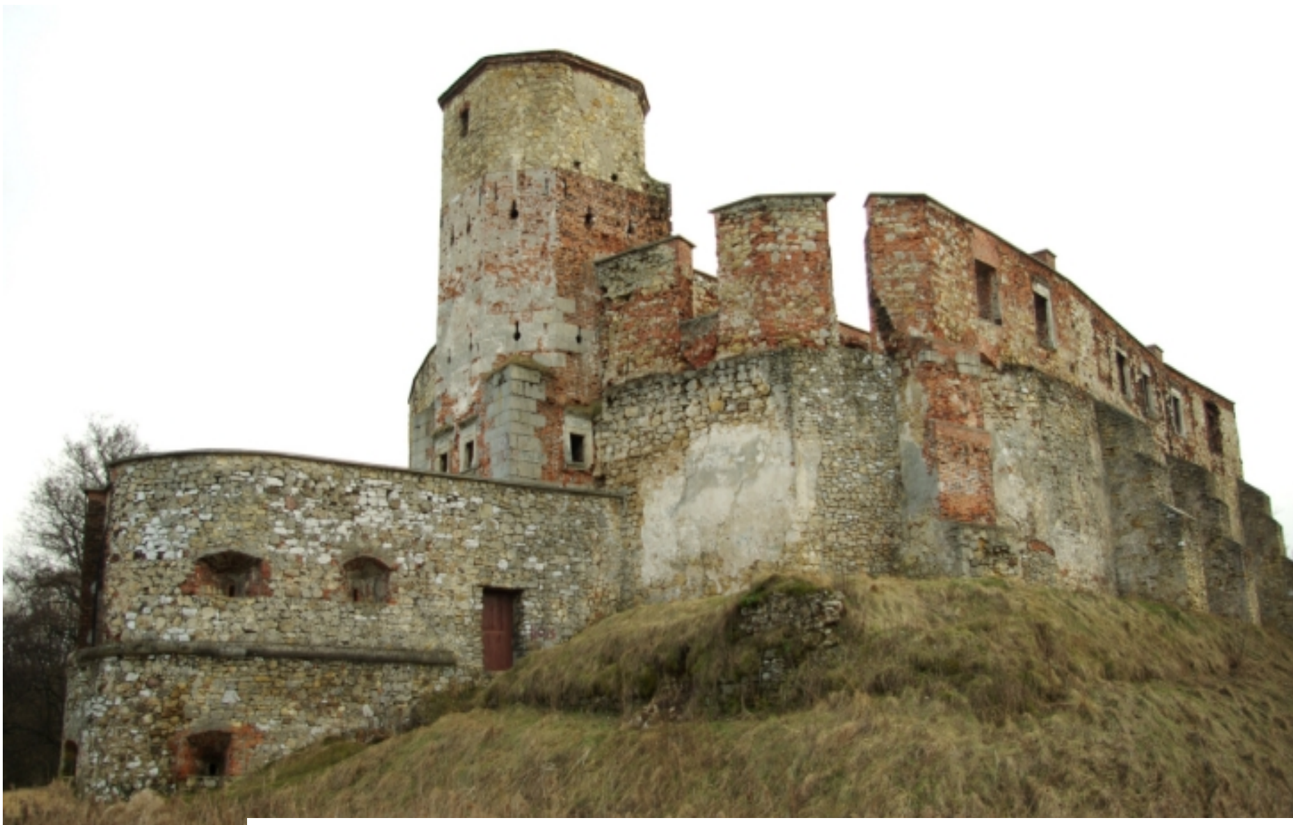
2.4. Zamek książąt śląskich, w latach 1443-1790 biskupów krakowskich – książąt siewierskich (Nr w rej. A/777/67). - przed rekonstrukcją i naprawą murów (luty 2008 r.)
