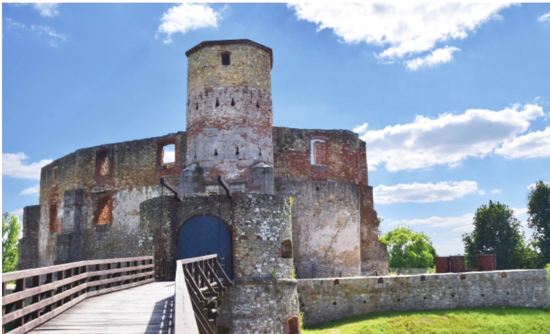
2.4. Zamek książąt śląskich, w latach 1443-1790 biskupów krakowskich – książąt siewierskich (Nr w rej. A/777/67) Po remoncie. Widoczne: kładka dla pieszych i most zwodzony.
