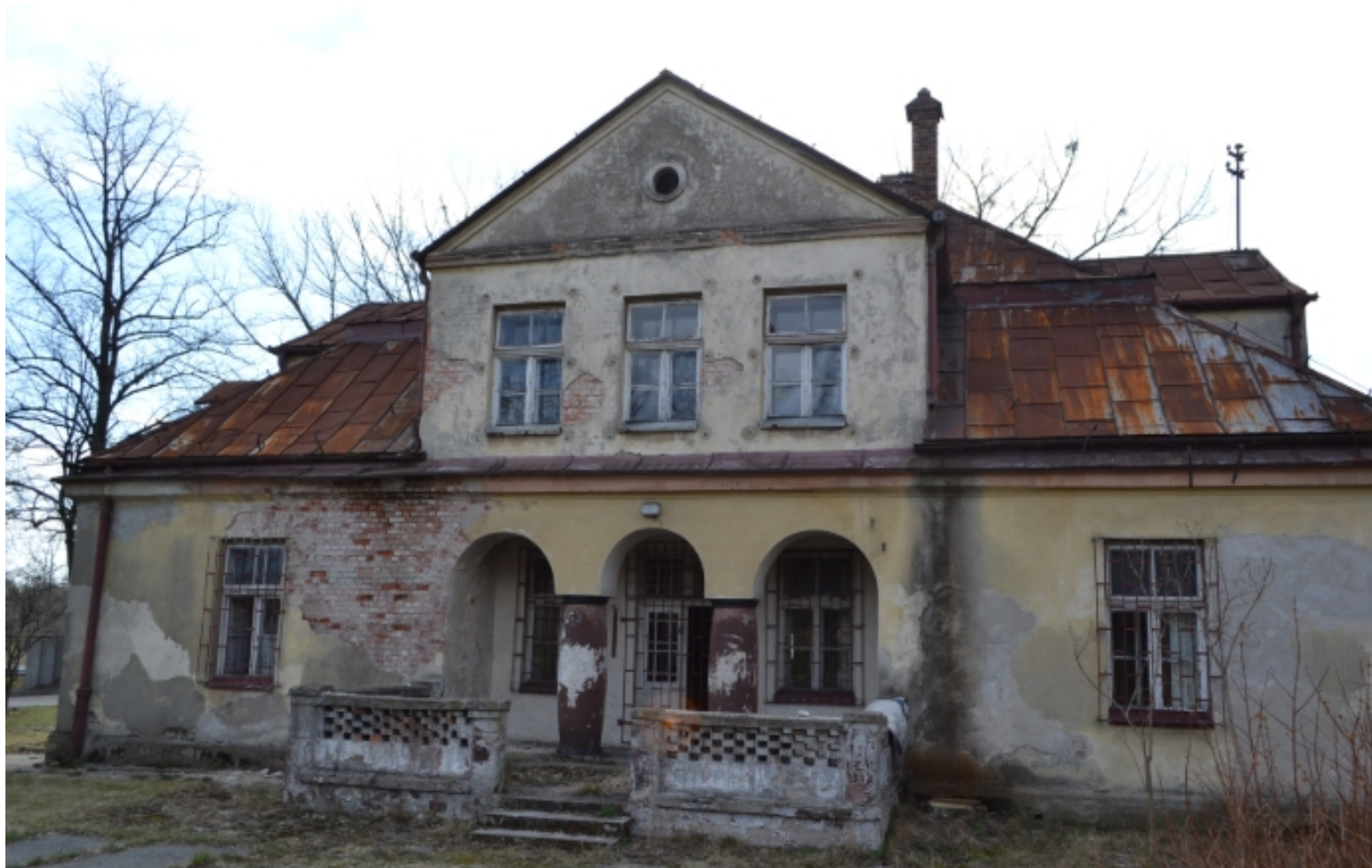
3.22 Zespół budynków Szpitala Gruźliczego w Siewierzu przy ul. Oleśnickiego 21. Willa.
