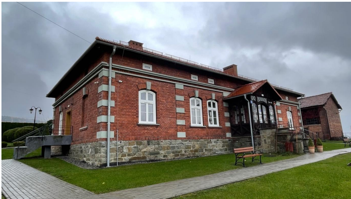
Dawna plebania przy kościele św. Bartłomieja w Lipowej po kompleksowym remoncie. Wzniesiona w konstrukcji murowanej na planie wydłużonego prostokąta na kamiennej podmurówce w 1896 r.
