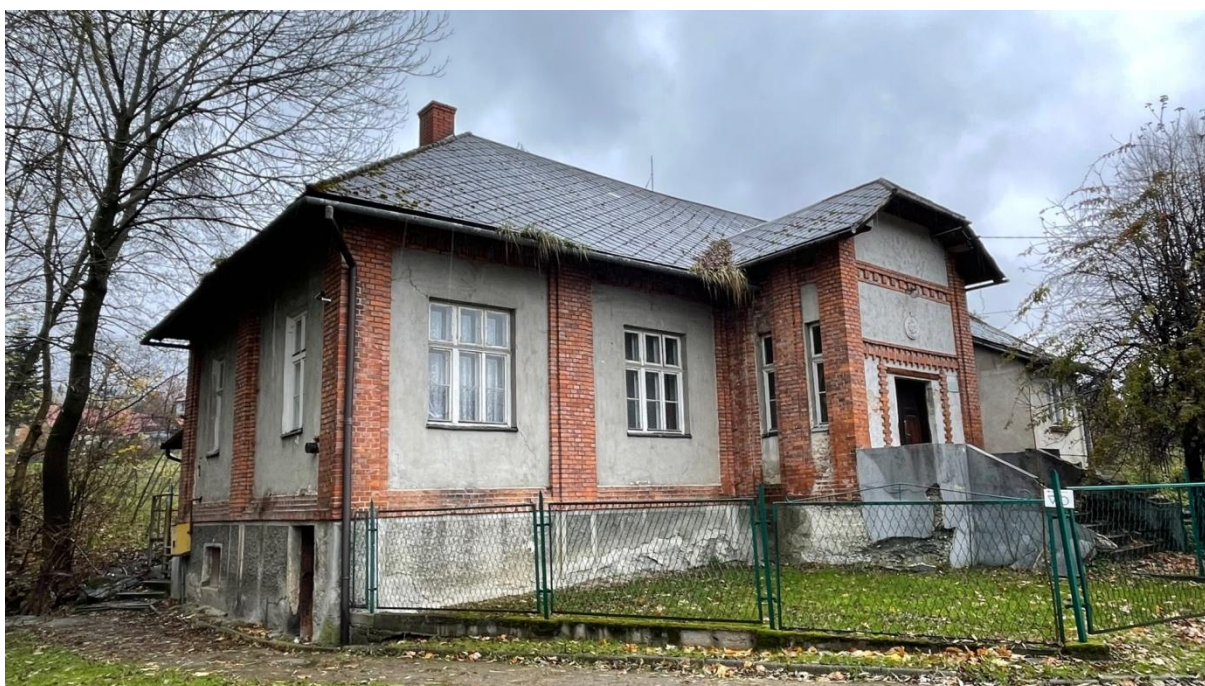
Dom parafialny przy kościele św. Bartłomieja w Lipowej wzniesiony k. XIX w. w konstrukcji murowanej. Podmurówka w tynku odciganym. Elewacje tynkowane z dekoracją ramowo-płycinową wykonaną z cegły. Okna skrzynkowe. Dach kopertowy kryty eternitem. Od strony wschodniej wydatny ganek kryty daszkiem naczółkowym. Budynek przeznaczony do kompleksowego remontu i adaptacji.
