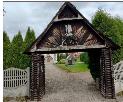
Fot.8. Brama drewniana przykryta daszkiem. Resztką dawnego ogrodzenia cmentarza w Łękawicy.
