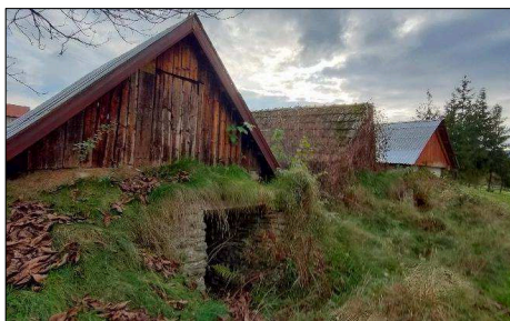
Fot. 3. Zespół siedmiu piwnic (Łękawica, ul. Za Wodą/Kalinowa)
