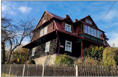
Fot.1. Willa „Sitajka” o konstrukcji drewnianej, zrębowej, przyziemie murowane z kamienia piaskowego, (Łękawica, ul. Brzozowa)
