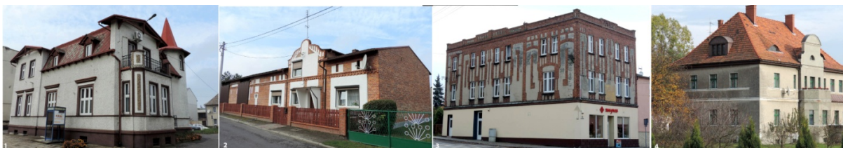
Fot. 15. 1. Wielowieś, ul. Główna 25; 2. Wielowieś, ul. Gminna 10; 3. Wielowieś, ul. Szkolna 1; 4. Zacharzowice, ul. Wiejska 49.
