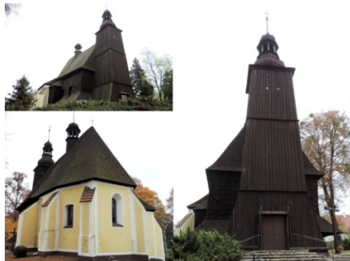
Fot. 1. Sieroty. Kościół parafialny p.w. Wszystkich Świętych (foto źródło: Gminna Ewidencja Zabytków).
