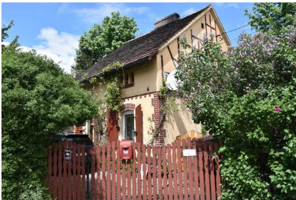
Fot. 3. Jejkowice. Budynek mieszkalny, ul. Przed Koleją 4 (foto źródło: Gminna Ewidencja Zabytków).
