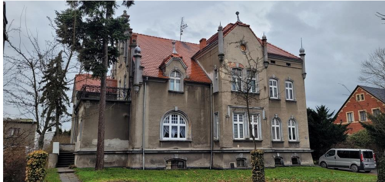
fot. 120 Pszczyna ul. Ks. bp. Bogedaina 6
