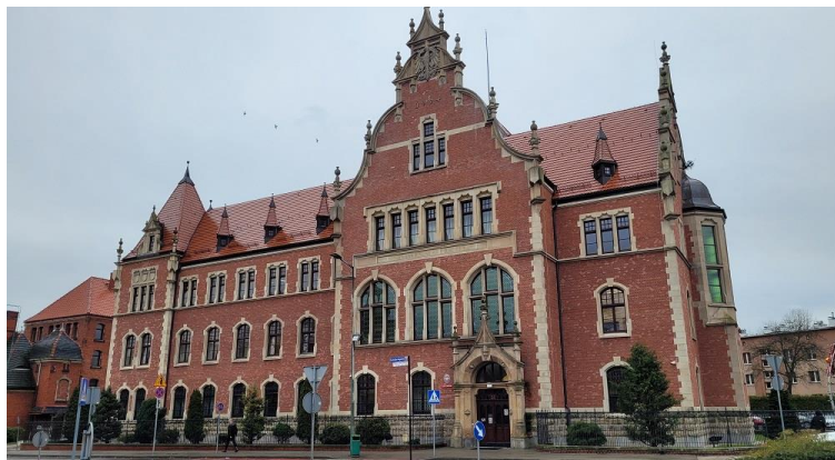
fot. 38 Pszczyna, ul. ks. bp. Bogedaina 14
