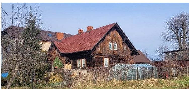
fot. 3 Dom, Poręba, ul. Wodna 13
