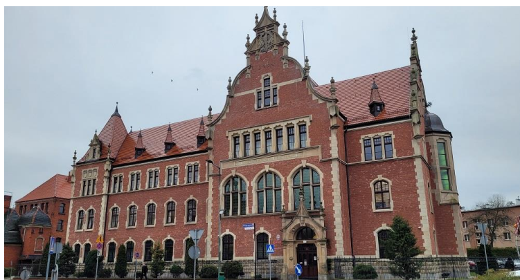
fot. 123 Pszczyna ul. Ks. bp. Bogedaina 14
