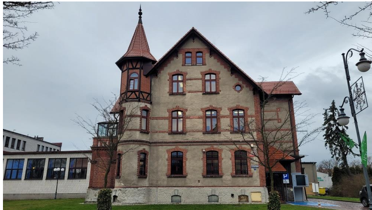
fot. 122 Pszczyna ul. Ks. bp. Bogedaina 8
