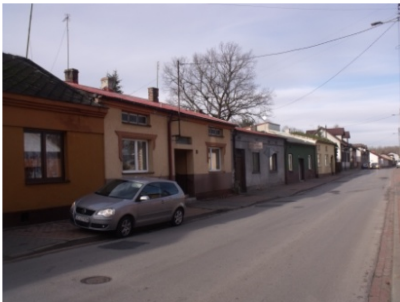
Mstów, zmodernizowane domy przy ul. Wolności
