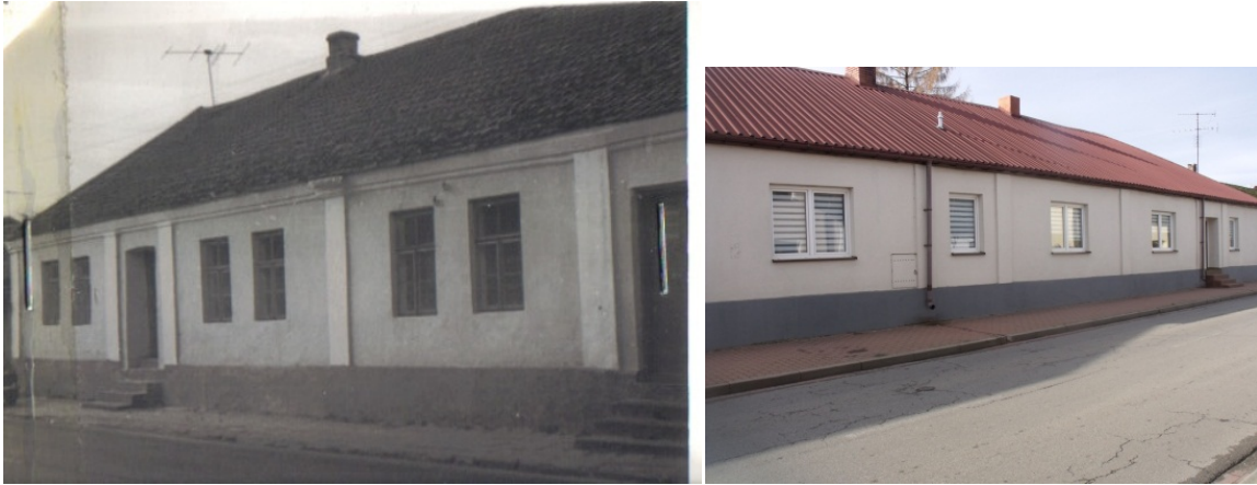
Mstów, dom, ul. Wolności 16, przed remontem (1990 r.) i po remoncie 2019
