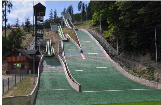
Fotografia 1. Widok na Kompleks skoczni narciarskich w Wisła Centrum.
