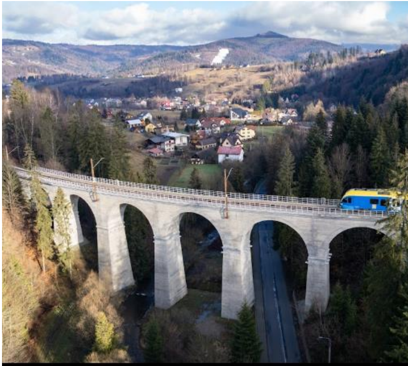
Fotografia 3. Widok na wiadukt kolejowy w Wiśle Łabajowie.
