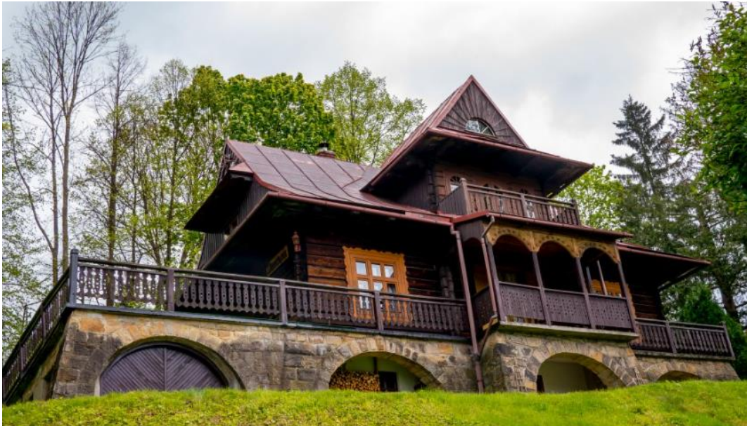
Fotografia 2. Widok na wille Dąbrówka – przykład drewnianego budownictwa willowego w Wiśle.
