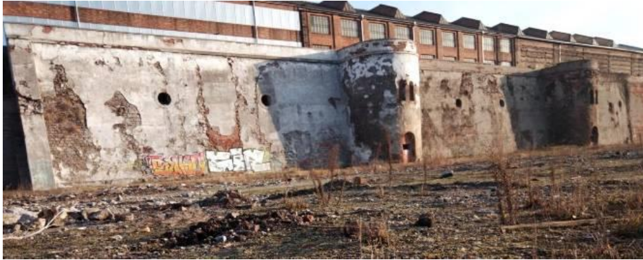
Fotografia 18. Fragmentu muru oporowego w obrębie Huty Zabrze
