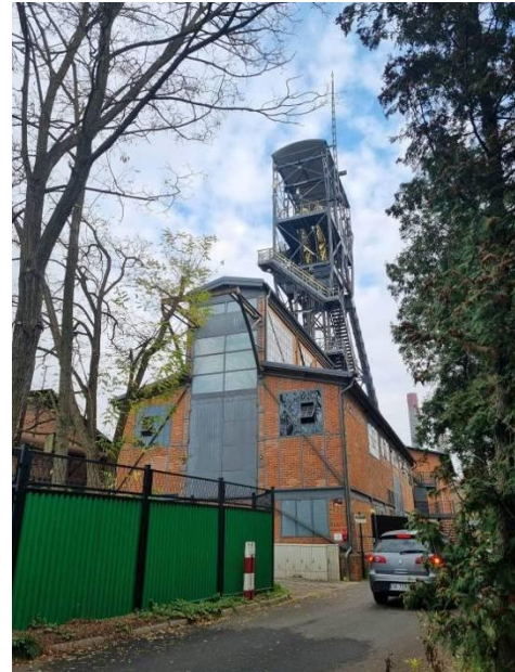
Fotografia 14. Fragment zabudowy dawnej kopalni „Królowa Luiza”
