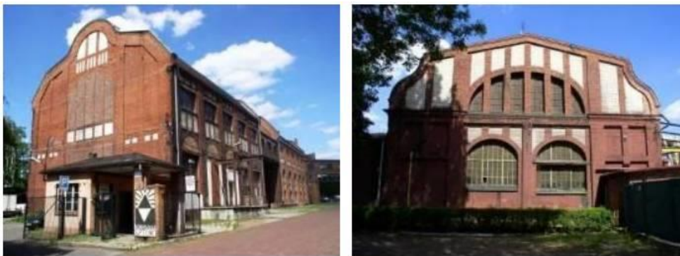
Fotografia 17. Zespół zabudowy kopalni Ludwik przy ul. Hagera, budynki szatni i łaźni oraz hali warsztatowej z kuźnią [1]
