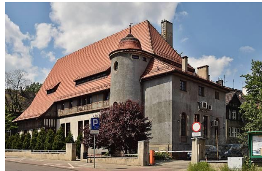
Fotografia 39. Budynek dawnego przedszkola, obecnie siedziba Straży Miejskiej, przy ul. Stalmacha 9 [1]
