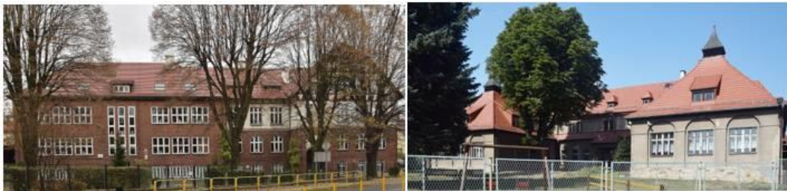
Fotografia 38. Budynek szkoły podstawowej i przedszkola na osiedlu Ballestrema w Zabrzu Rokitnicy [1]
