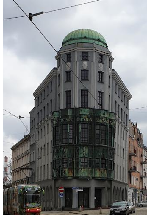
Fotografia 36. Budynek dawnego hotelu Admiralspalast
