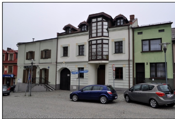
Fotografia 1. Budynek narożny nr 1-3 w zachodniej pierzei kłobuckiego Rynku
