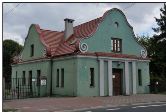
Fot. 9-10 Budynek przy ul. Wieluńskiej 11 w Kłobucku
