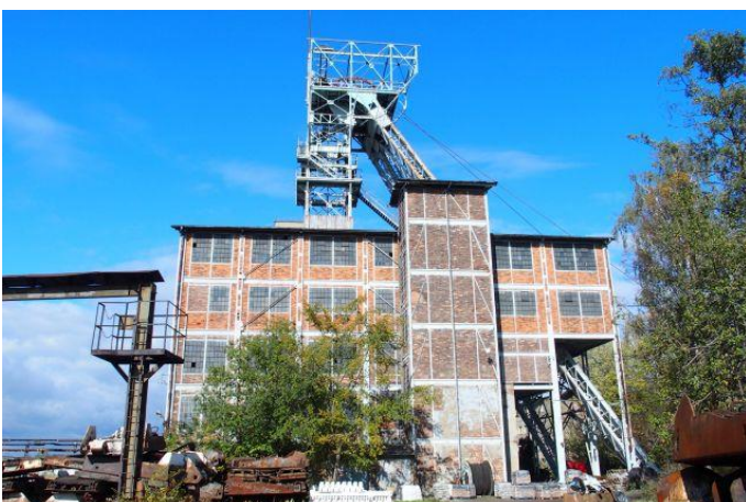
Zdjęcie nr 6. Budynek nadszybia „Guido” z wieżą szybu Foch I w zespole KWK „KNURÓW-SZCZYGLÓWICE” Pole Zachód
