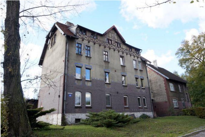
Zdjęcie nr 41. Budynek mieszkalny ul. Dworcowa 42
