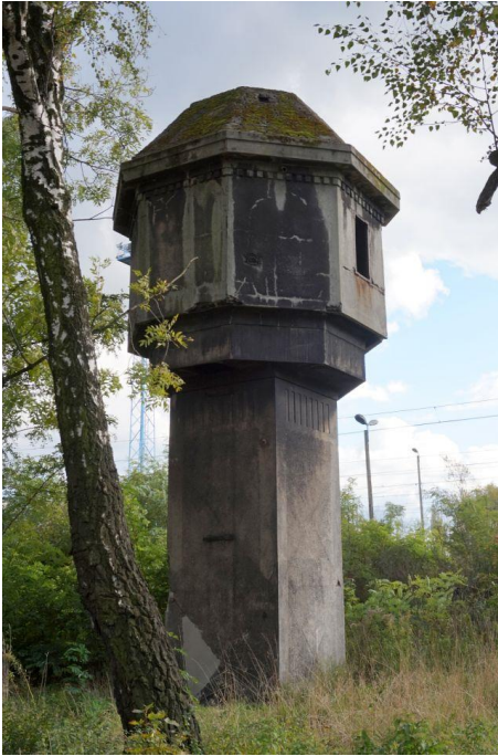
Zdjęcie nr 8. Wieża ciśni, ul Dworcowa 44
