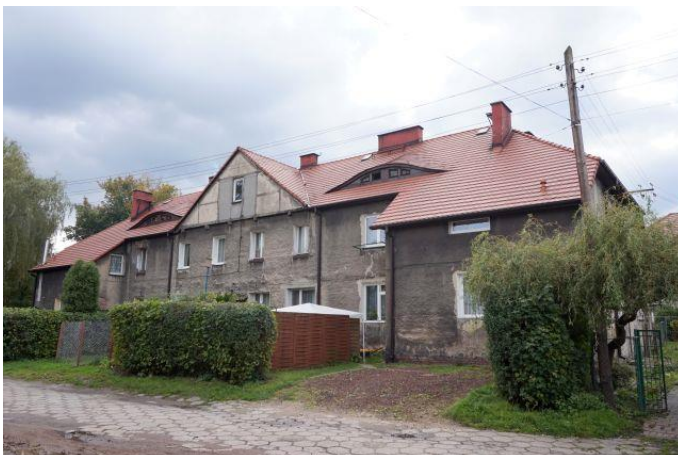
Zdjęcie nr 34. Budynek mieszkalny, wielorodzinny, ul. Kozielka 42
