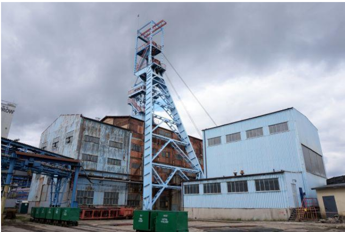
Zdjęcie nr 5. Budynek nadszybia „Von Velsen” w zespole KWK „KNURÓW-SZCZYGLÓWICE”
