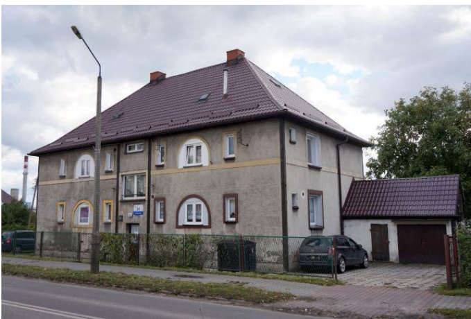
Zdjęcie nr 38. Budynek mieszkalny, ul. Dworcowa 14
