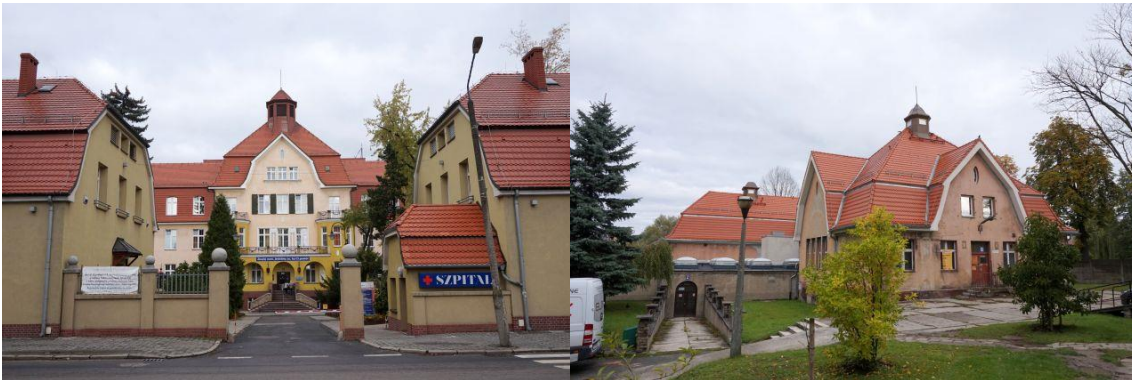
Zdjęcia nr 18, 19. Budynki w zespole szpitala spółki brackiej, ob. szpital w Knurowie sp. z o.o., ul. Niepodległości 6-8
