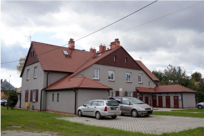
Zdjęcie nr 36. Budynek mieszkalny, ul. Dworcowa 13
