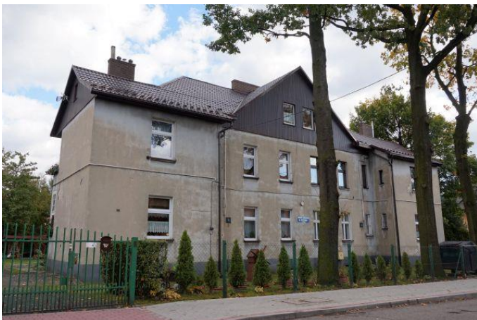
Zdjęcie nr 33. Budynek mieszkalny, wielorodzinny, ul. Poczta 1
