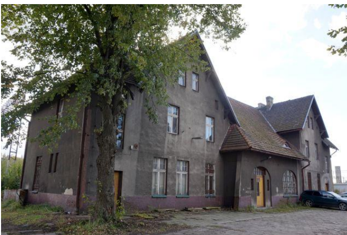
Zdjęcie nr 7. Dawny dworzec PKP, ul. Dworcowa 44
