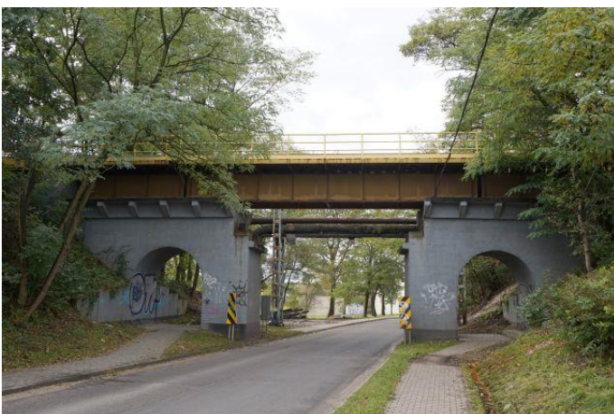
Zdjęcie nr 9. Wiadukt kolejowy, ul. Wilsona
