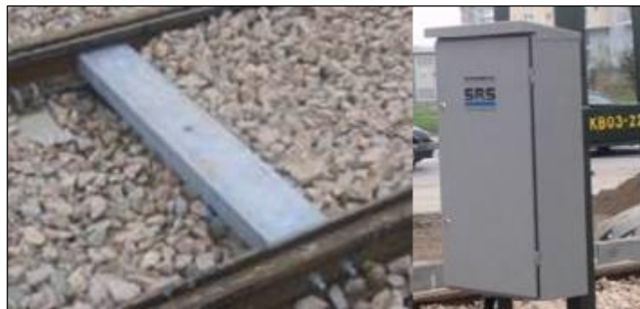
Rysunek 9. Przykład smarownicy torowej SRS oraz szafy z aparaturą sterowniczą smarownicy
