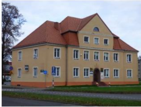
Fot. 17. Dawne kasyno oficcerskie przy al. Powstańców Wlkp. 63
