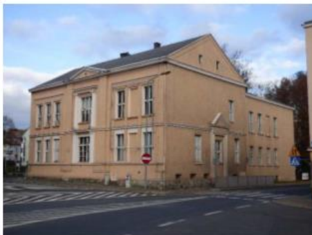
Fot. 8. Budynek dawnej loży masońskiej Borussia
