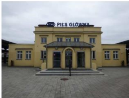
Fot. 18. Zespół stacji kolejowej Piła Główna
