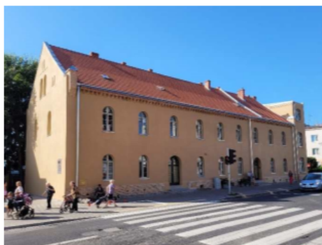
Fot. 5. Budynek dawnego arsenału
