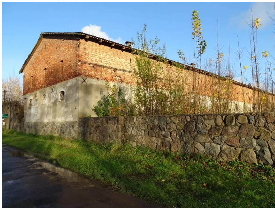
Bytowo, budynek inwentarski i ogrodzenie, fot. 2023
