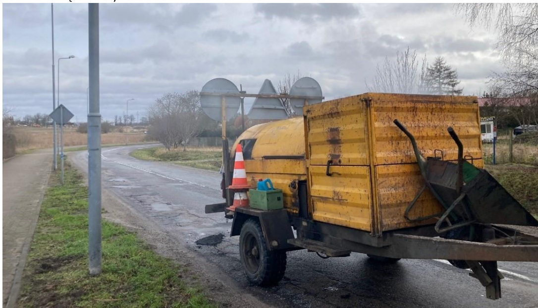
Remont cząstkowy nawierzchni Patcherem
