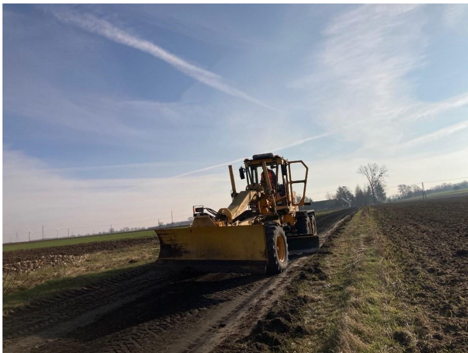
Profilowanie i uzupełnianie nawierzchni na drodze gruntowej Morowo - Siemyśl
