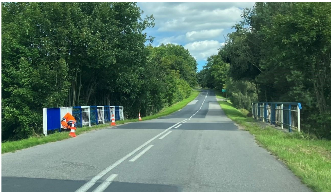
Malowanie barier na moście w Nieżynie
