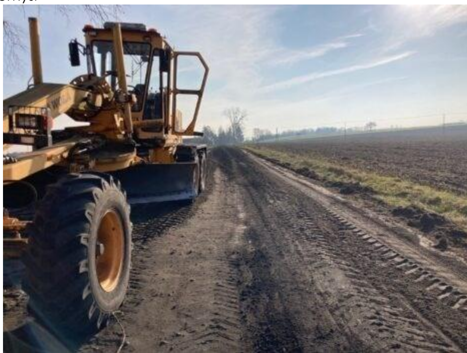
Profilowanie i uzupełnianie nawierzchni na drodze gruntowej Morowo - Siemyśl
