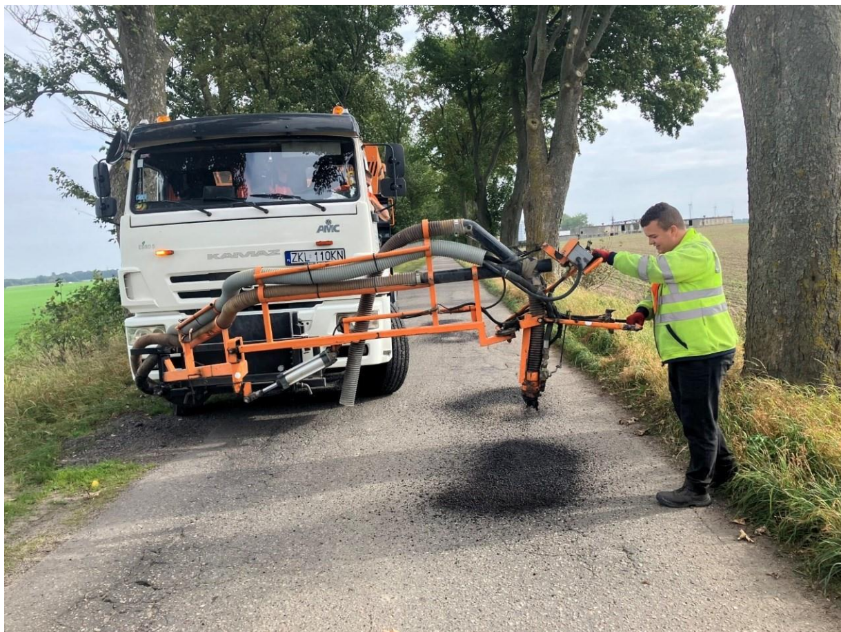
Remont cząstkowy nawierzchni Patcherem
