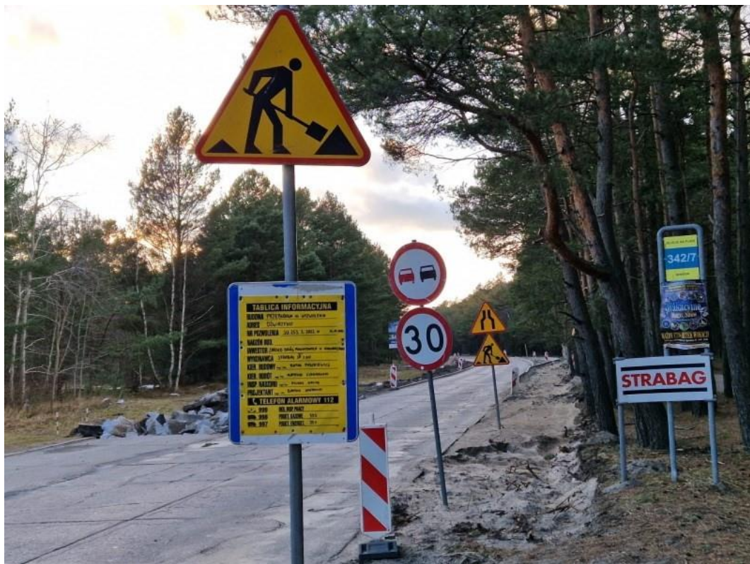
Postęp prac przy inwestycji w Dźwirzynie
