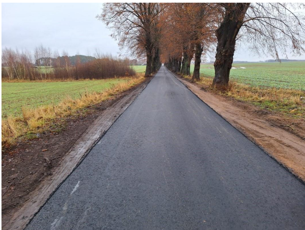
Wykonanie nowych warstw bitumicznych na drodze nr 3317Z Ząbrowo –
