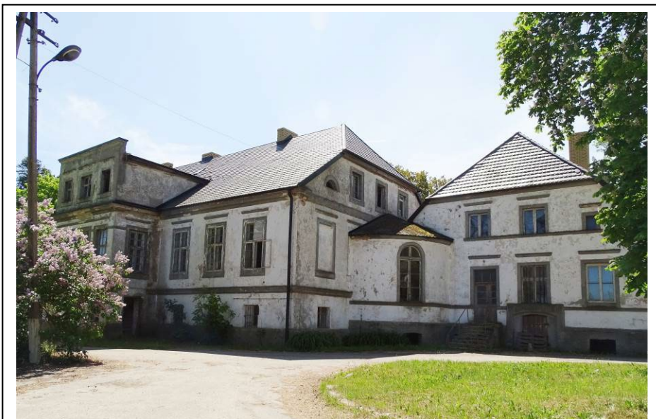
Kładno – pałac (nieużytkowany) – XIX w.
