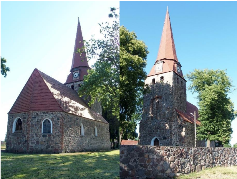
Zdjęcia nr 17, 18. Kościół filialny pw. św. Antoniego, Żukowo
