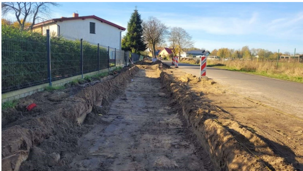
Budowa chodnika w Starym Borku
