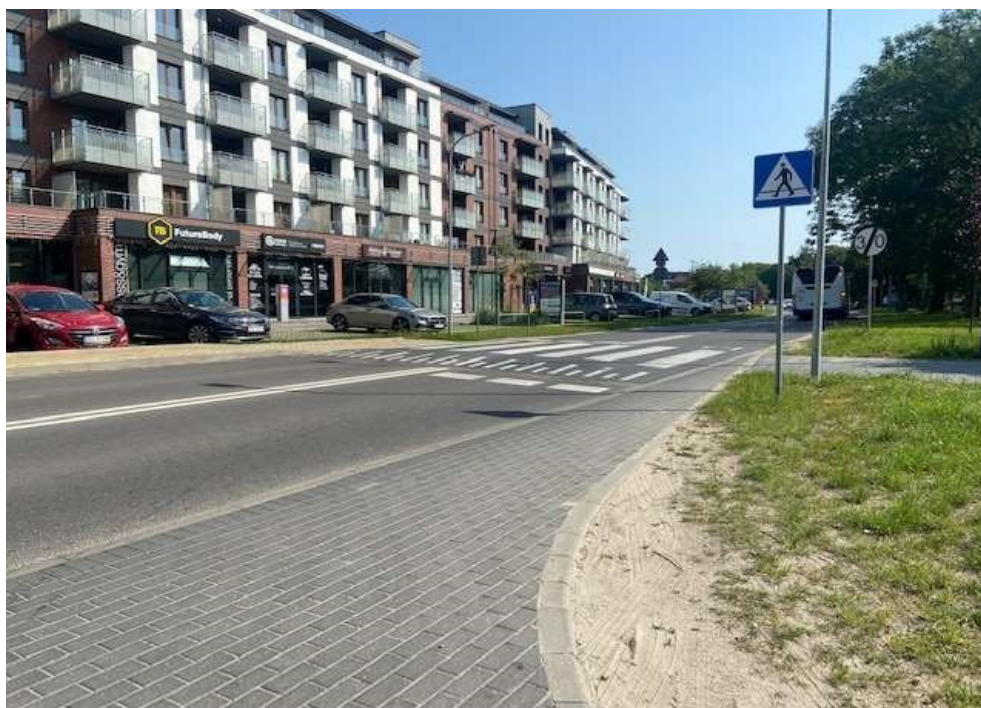
Wyniesione przejście dla pieszych przy ulicy Mazowieckiej w Kołobrzegu.
