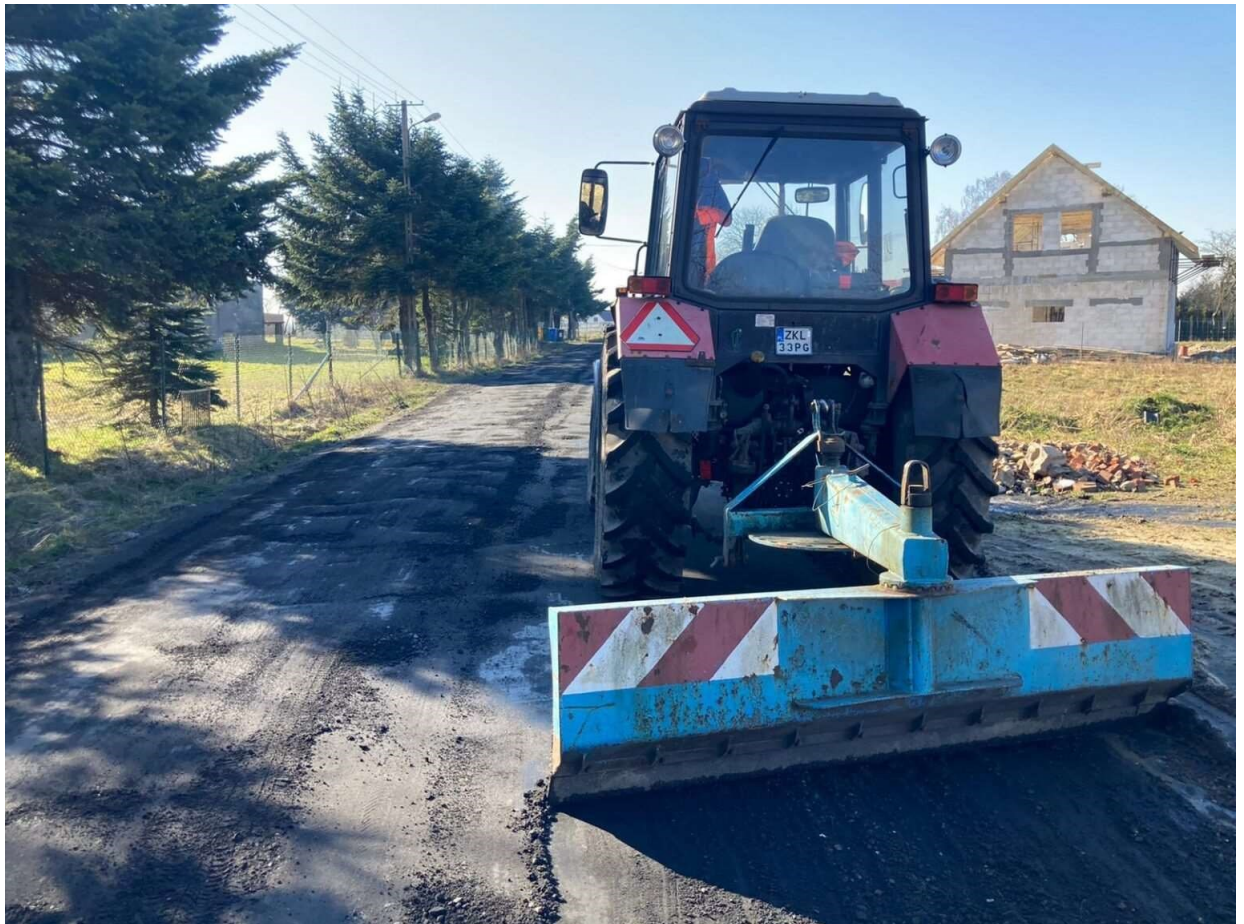
Profilowanie i uzupełnianie nawierzchni na drodze gruntowej
