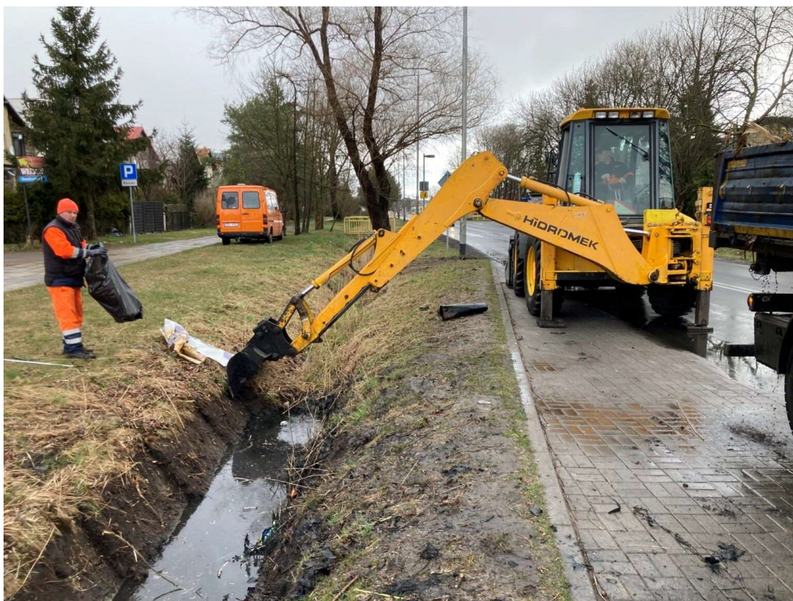
Oczyszczenie i pogłębienie rowu przy ulicy Grzybowskiej w Kołobrzegu
