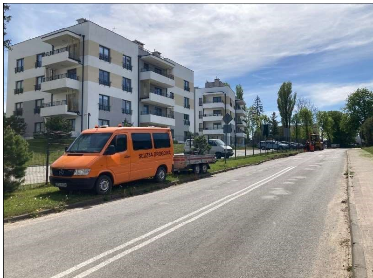
Naprawa jezdni i pobocza na ulicy Rolnej w Ustroniu Morskim.
