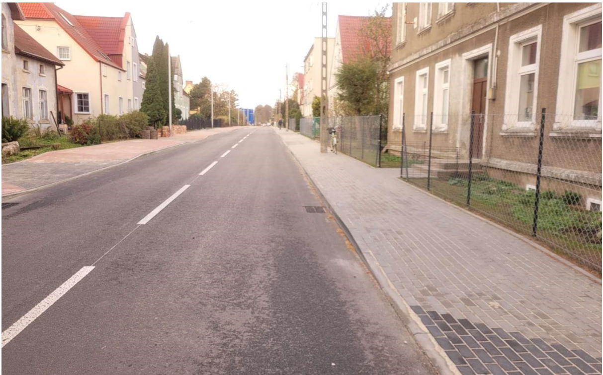
Ulica Lipowa w Gościnnie po przebudowie
