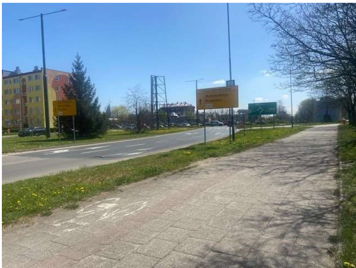
Ulica Myśliwska w Kołobrzegu przed przebudową
