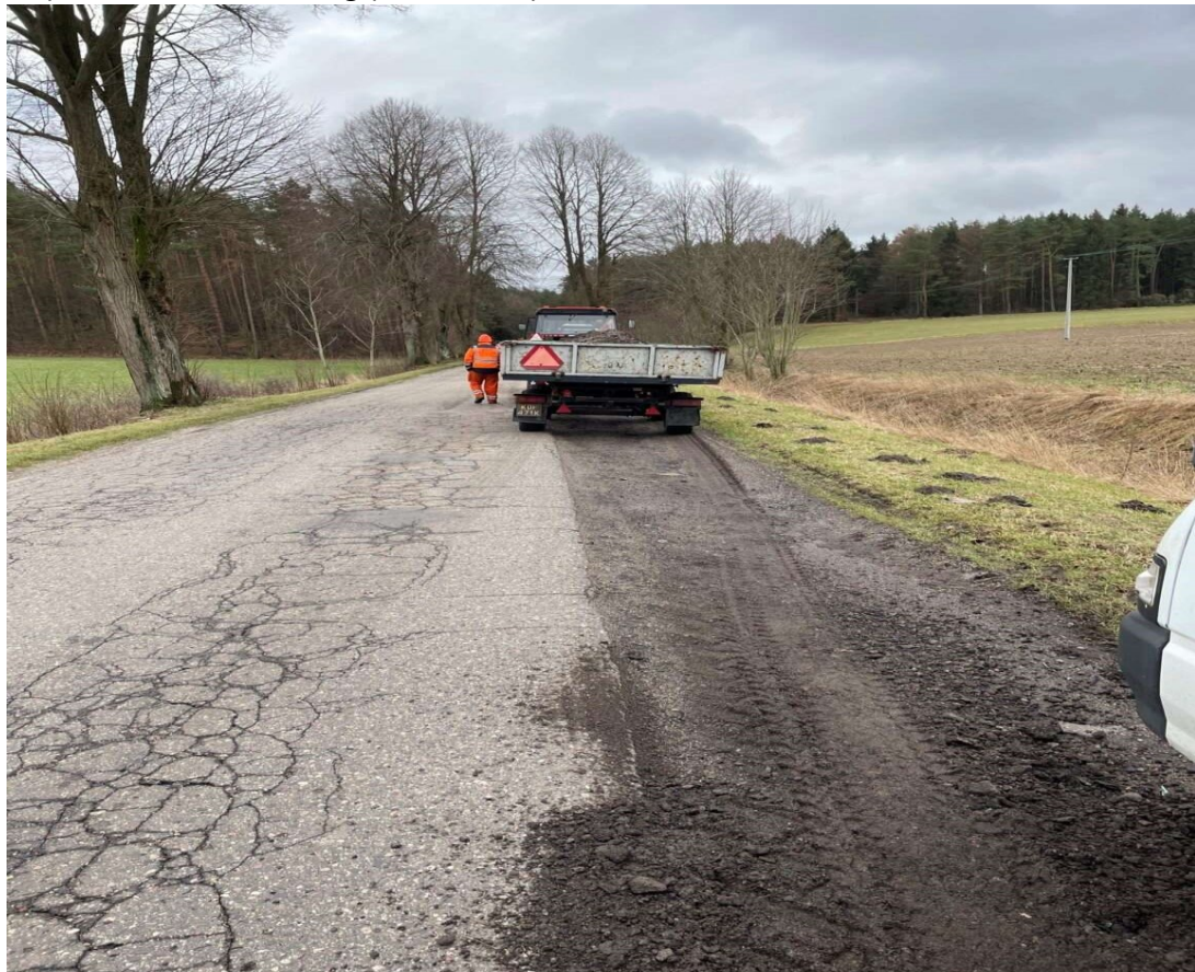
Remont pobocza przy drodze Bardy - Włóścibórz
