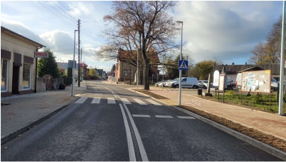
Ulica Główna w Dygowie po przebudowie
