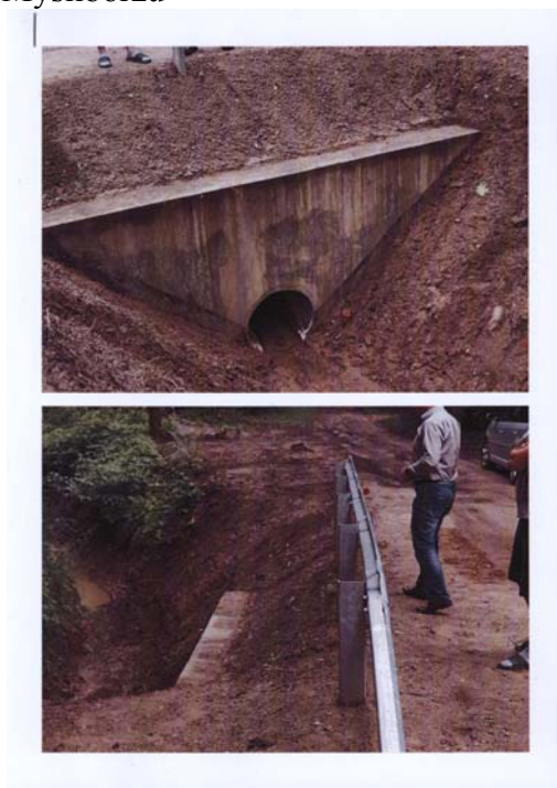
Remont przepustu w m. Krusze
