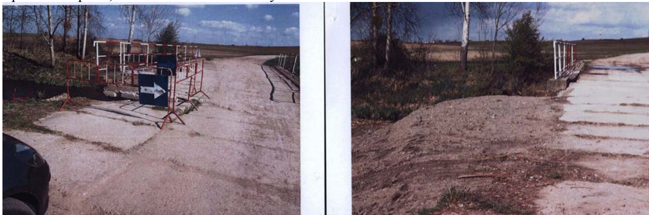
Naprawa przepustu w m. Wierzbówek
