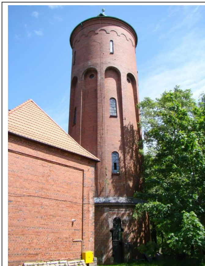
Wieża ciśnień, 1927 r. – ul. Koszalińska 23A
