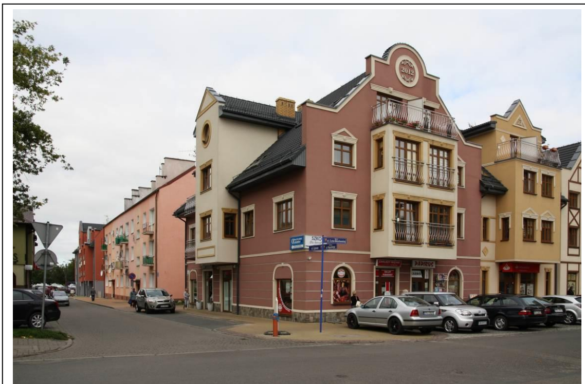
Nowa zabudowa - ul. Lipowa / Skłodowskiej
