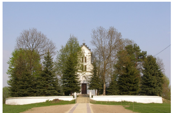
Kaplica Grobowa w Malicach
