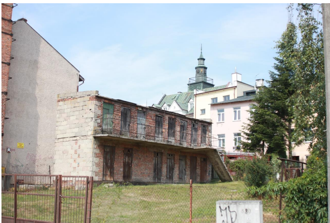
Substandardowa zabudowa przy ul. Partyzantów, na zapleczu Ratusza Miejskiego (fot. J. Dąbrowski)
