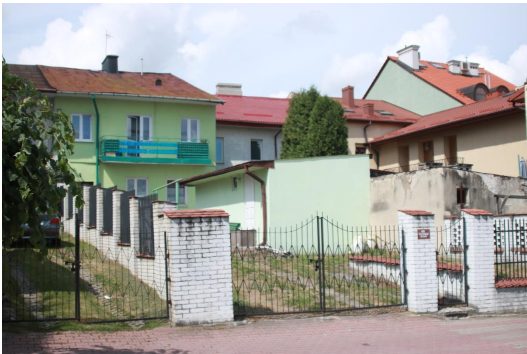
Substandardowa zabudowa przy ul. Browarnej, widoczny brak pierzei (fot. J. Dąbrowski)
