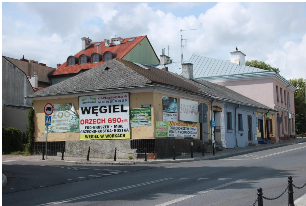
Budynek narożny ul. Mostowa 2 / ul. Browarna zasłonięty chaotycznymi reklamami (fot. J. Dąbrowski)
