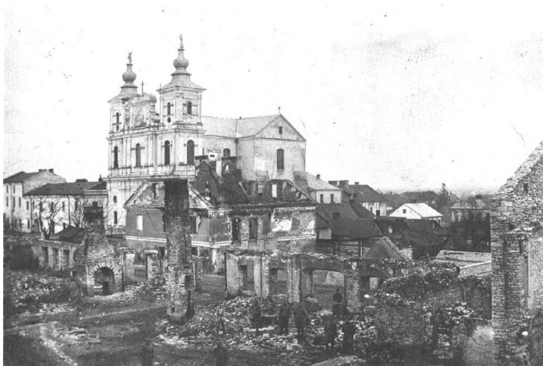
Zniszczenia miasta w wyniku walk w 1914 r. – na pierwszym planie budynki przy ul. Kościelnej (za: www.fotopolska.eu )
