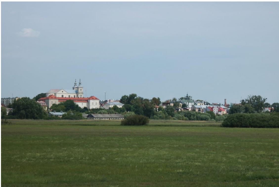
Widok Krasnegostawu od południa – widoczny maszt telefonii komórkowej, maszt PSP i komin kotłowni przy ul. Partyzantów 12. (fot. J. Dąbrowski)
