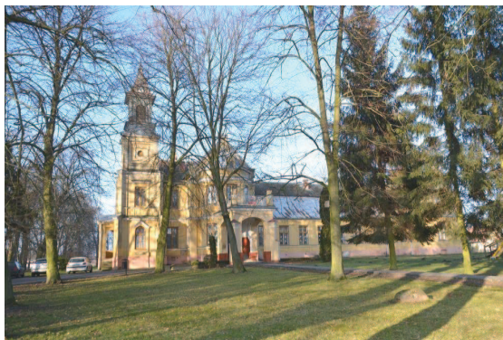
Zdj. 2. Pałac – widok na wejście główne oraz wieżę pałacową (DH)
