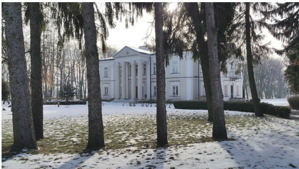
Zdj. 8. Widok na pałac oraz podjazd od strony północno-zachodniej (fot. MF)
