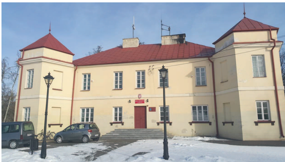
Zdj. 16. Pałac od strony wejścia głównego –część południowo-zachodnia (fot. MF)
