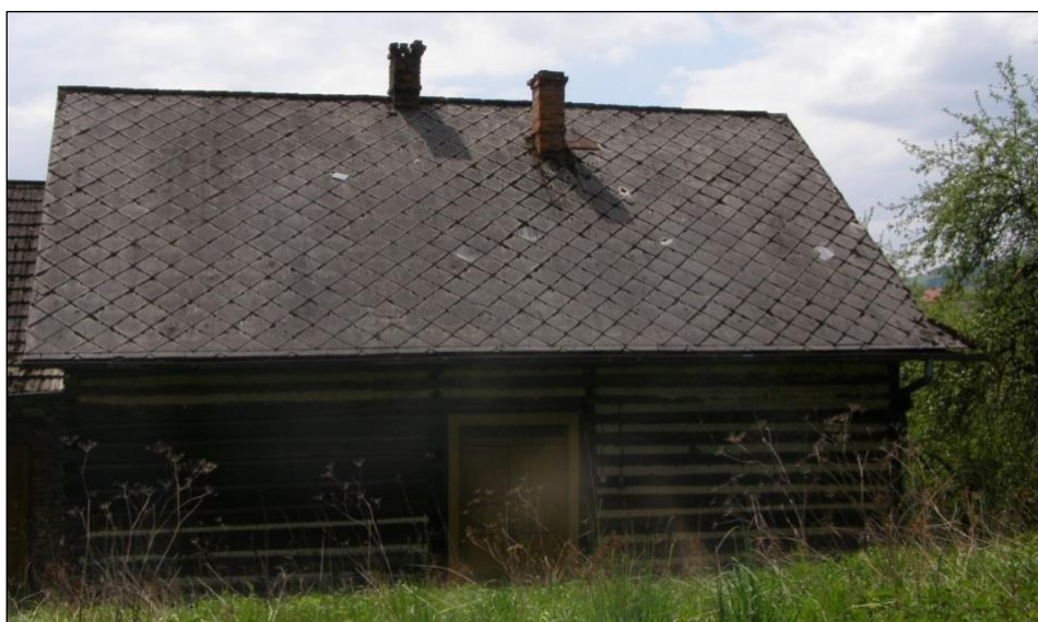
Rys. 5. Zdjęcie obrazujące wykorzystywanie wyrobów azbestowo-cementowych jako element pokrycia dachowego (płyty karo) źródło: zdjęcie własne
