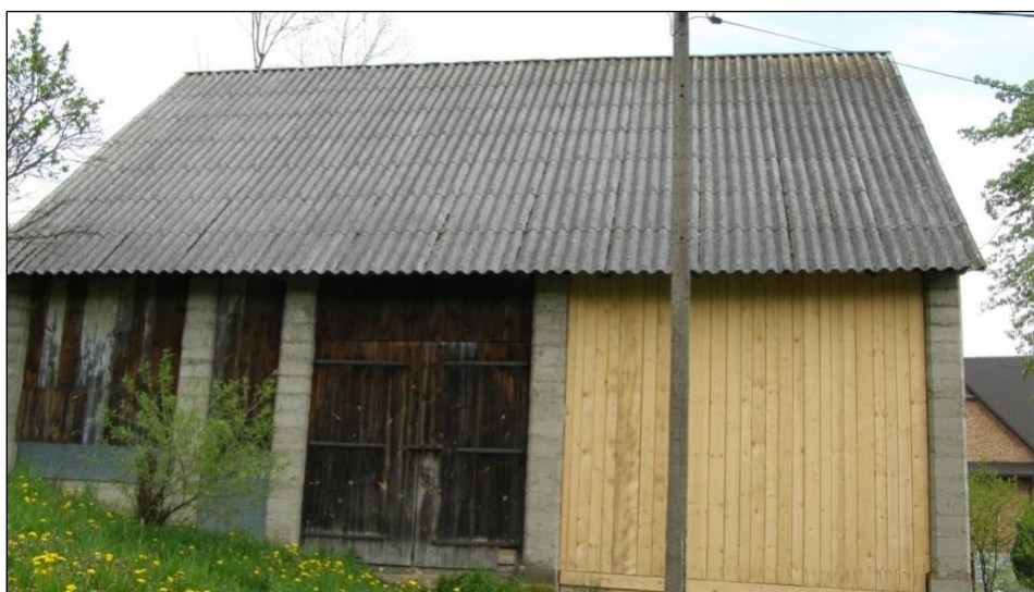
Rys. 6. Zdjęcie obrazujące wykorzystywanie wyrobów azbestowo-cementowych jako element pokrycia dachowego (eternit falisty), źródło: zdjęcie własne
