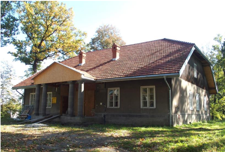
Zdjęcie nr 13. Dwór w Gieraltowicach, ul. Zatorska 8
