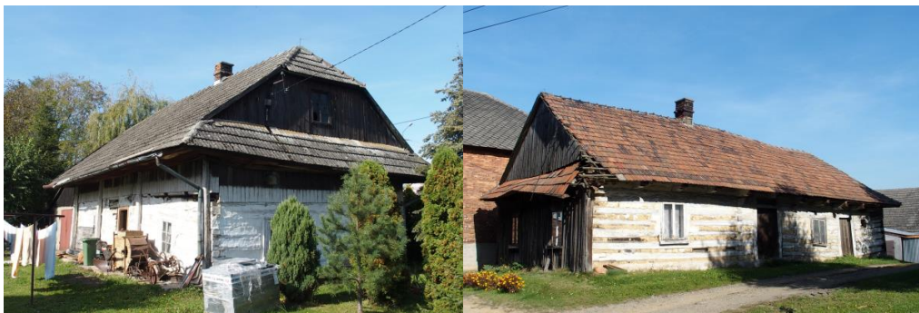
Zdjęcie nr 14. Gierałtowice ul. Św. Marcina 9
