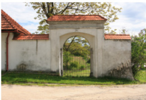
Brama wjazdowa w Garlicy Murowanej
