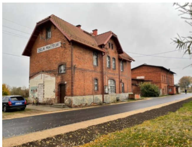
Fot. 17 Budynek stacji kolejowej z 1910 r. w Zielinie (fot. Dorota Misiaczyk-Struzik)
