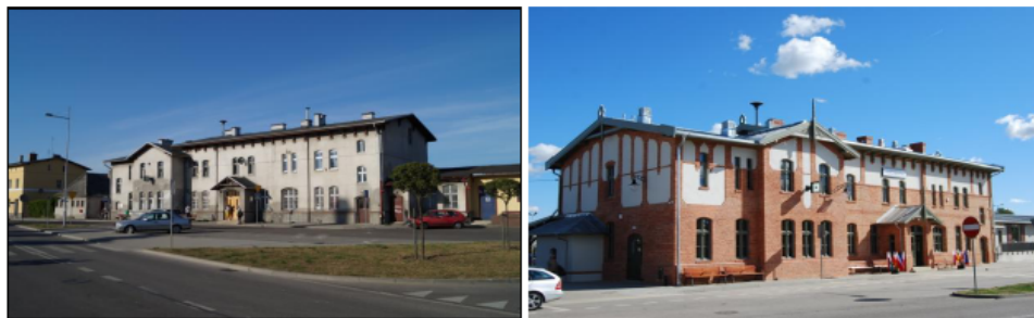
Fot. Dworzec kolejowy w Kościerzynie przed (2016r.) i po renowacji (2018r.)
