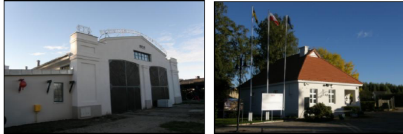
Fot. Zespół parowozowni z halą i budynkiem administracyjnym.
