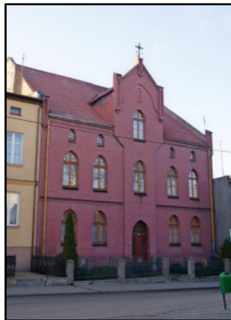
Fot. Fasada klasztoru od str. ul. Kaplicznej.
