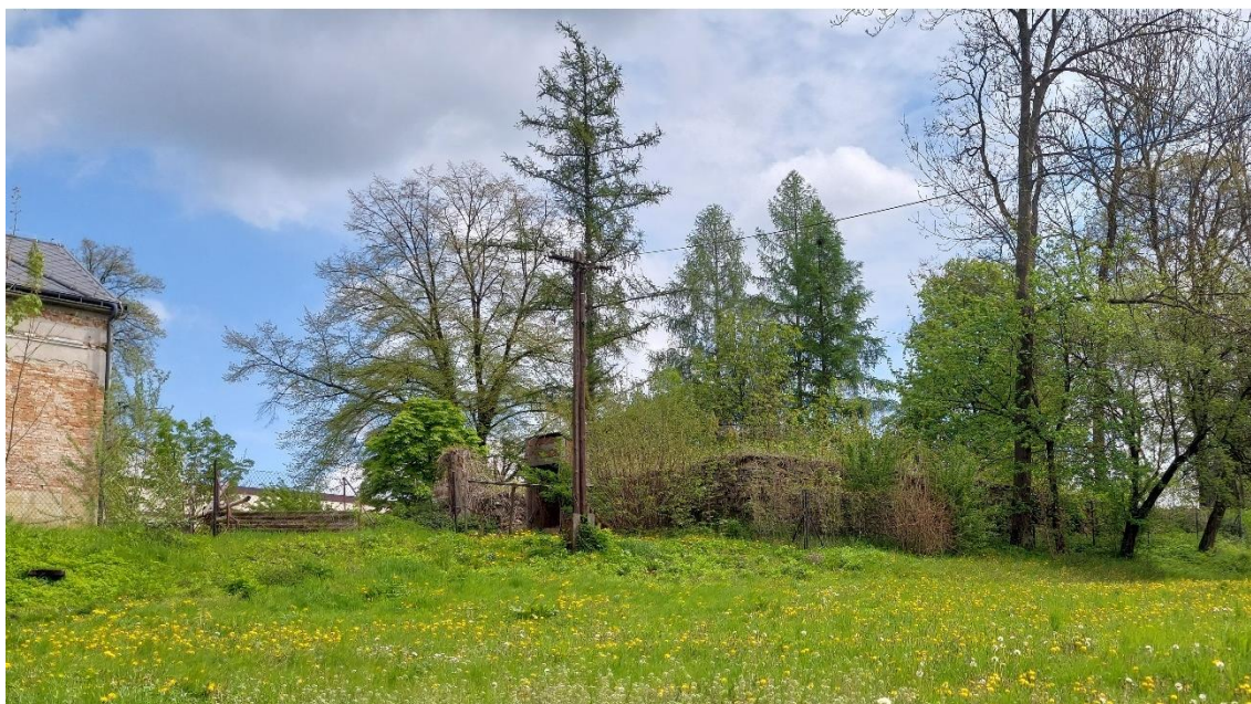
Fot. 10. Tarnowiec. Piwnice starego dworu (fot. autor opracowania).
