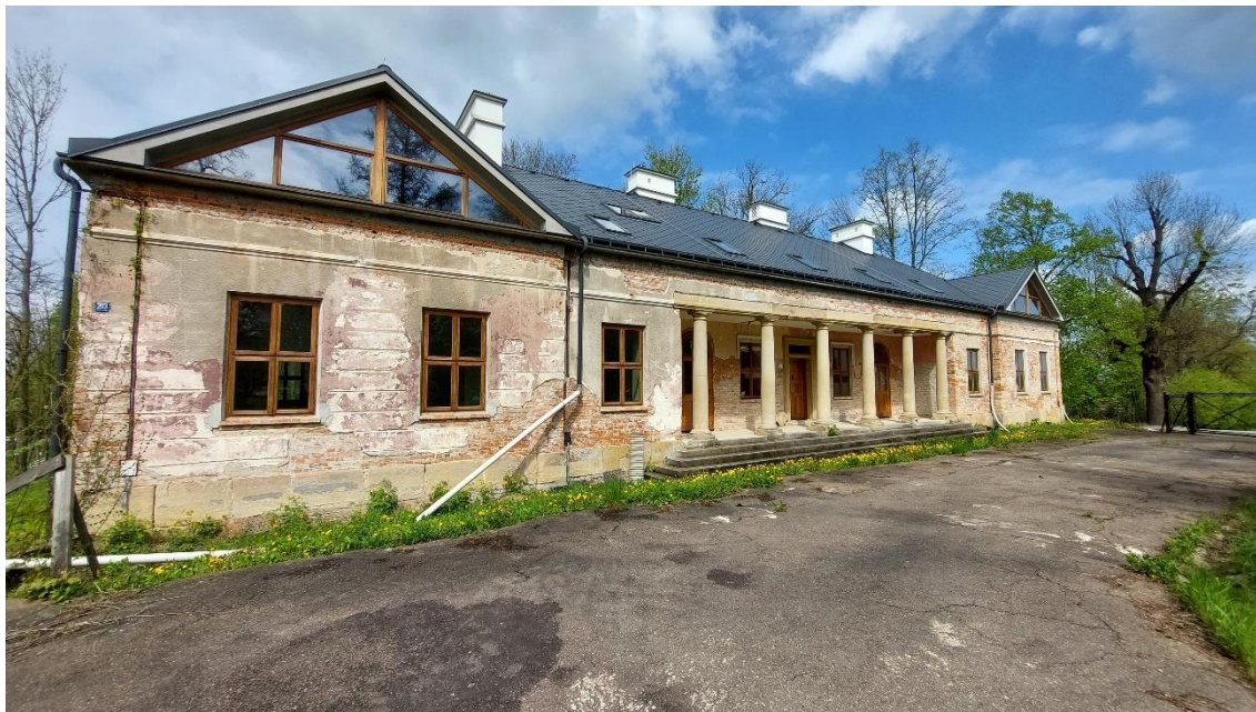
Fot. 9. Tarnowiec. Dwór Pilińskich (fot. autor opracowania).
