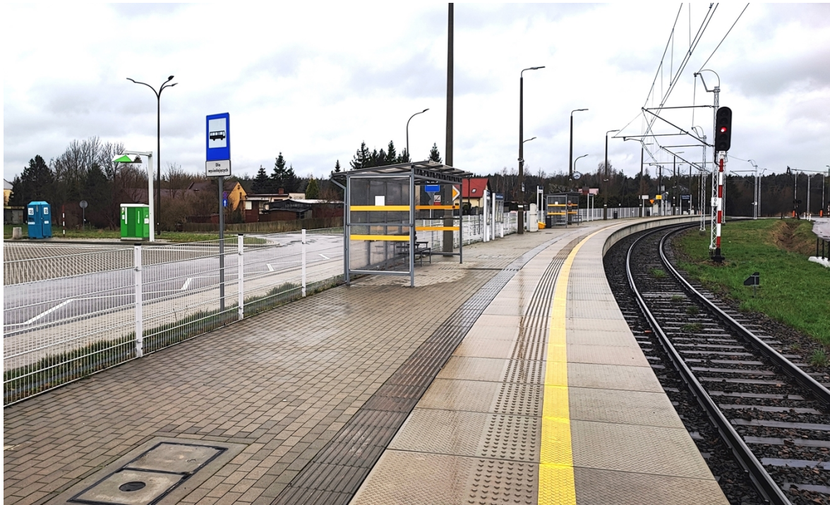
Rys. 4.2 Przystanek kolejowy Stalowa Wola Charzewice
