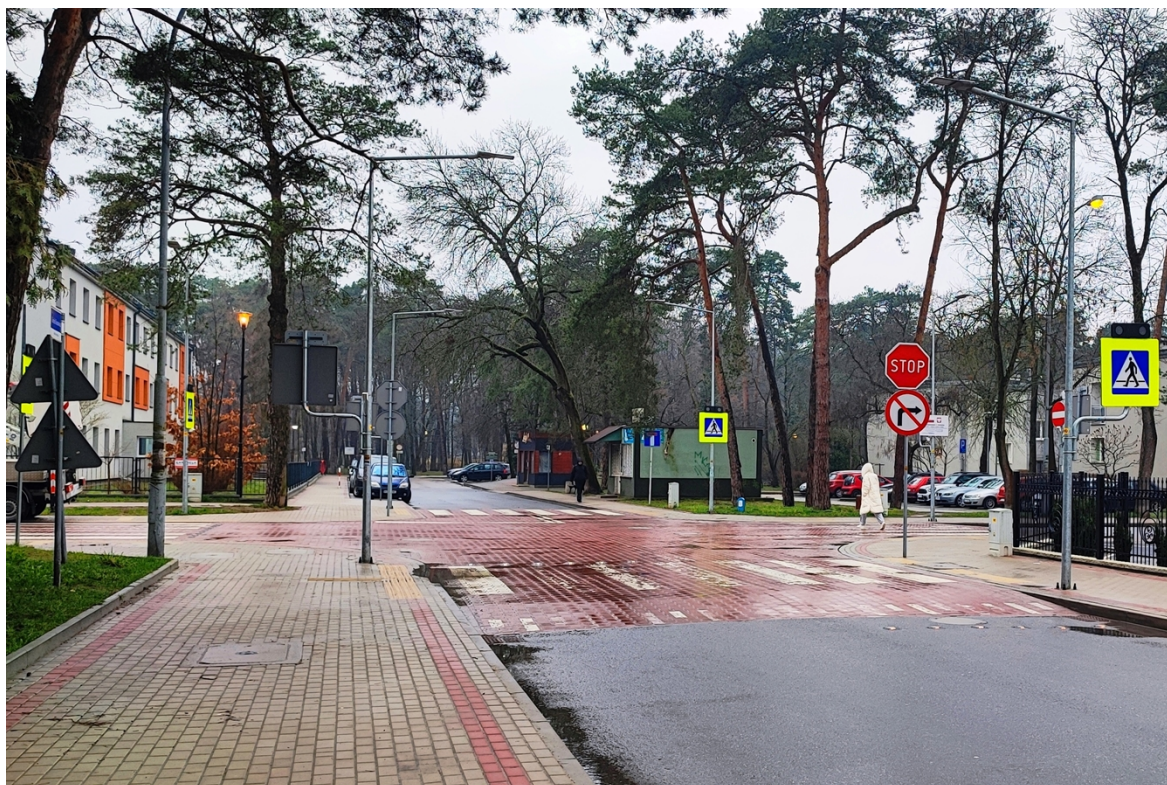
Rys. 4.12 Aktywne przejścia dla pieszych przy wyniesionym skrzyżowaniu ulic Skoczynskiego i Narutowicza w celu poprawy bezpieczeństwa pieszych w Stalowej Woli.
