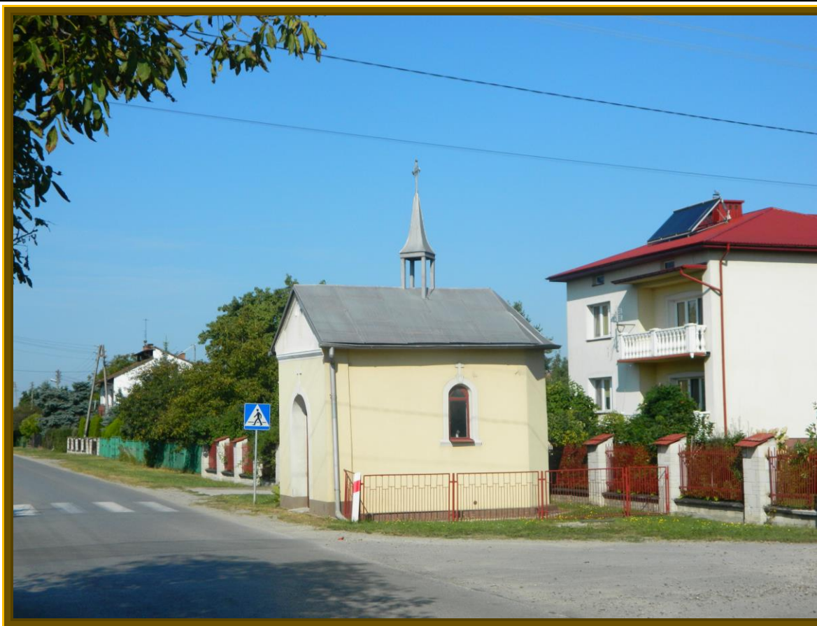
Przedzel – Kaplica przy ul. Wolińskiej
