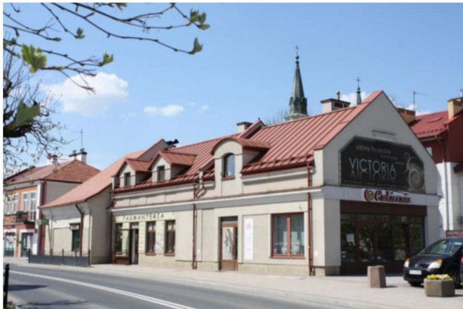
Ropczyce, Budynek dawnej poczty konnej, ul. Mickiewicza 1-6
