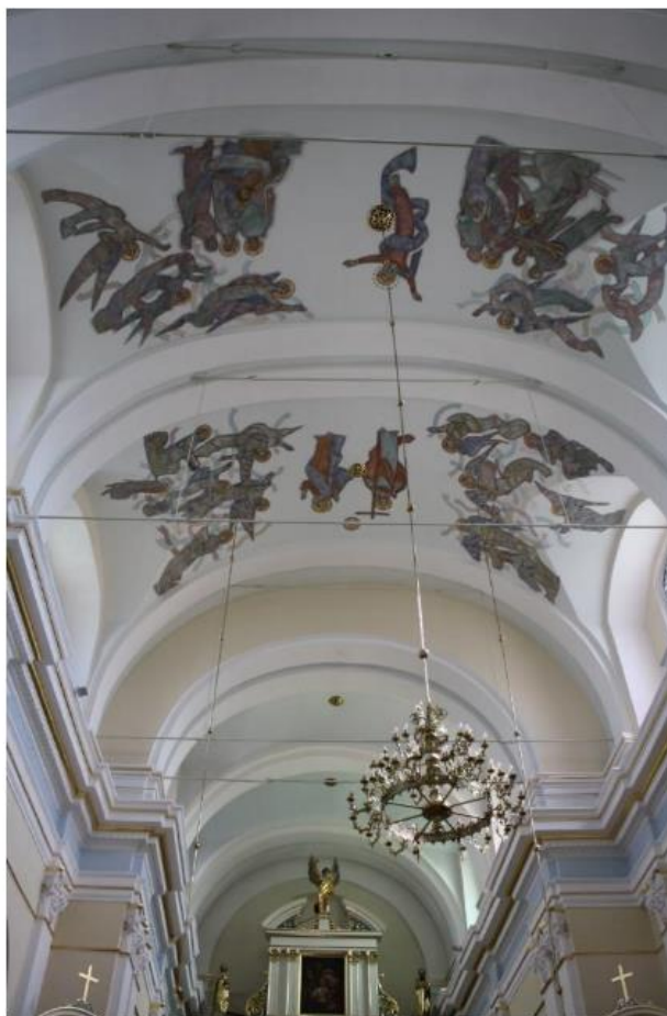
Sędziszów Małopolski; Zespół kościoła par. p.w. Narodzenia NMP, wnętrze kościoła
