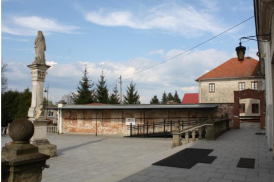
Sędziszów Małopolski; Zespół Klasztorny OO. Kapucynów, kościół p.w. Św. Antoniego Padewskiego, mur.1739-1756, dwupoziomowy taras. Na niższym tarasie stoi rzeźba Matki Boskiej Niepokalanie Poczętej
