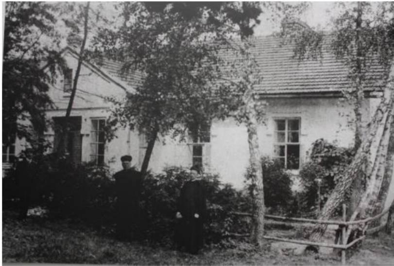
Wielopole Skrzyńskie, Budynek plebanii, lata 20. XX w.
