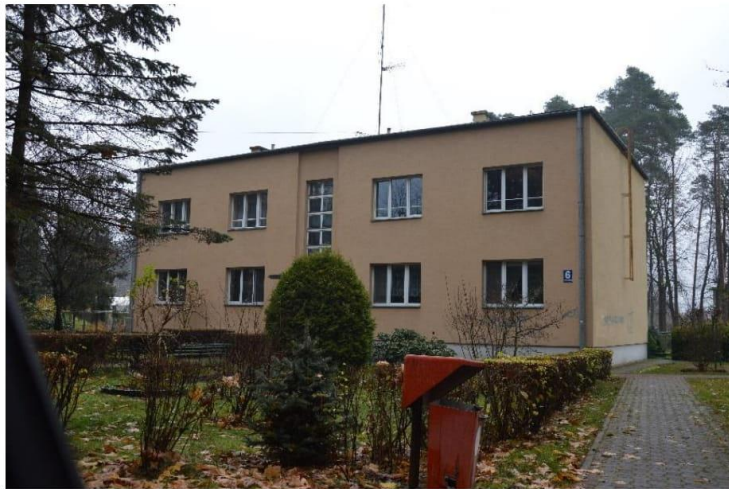
Fot. 21. Jeden z budynków osiedla mieszkalnego w Nowej Sarzynie
