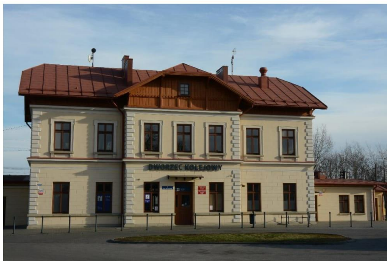
Fot. 19. Dworzec kolejowy w Leżajsku
