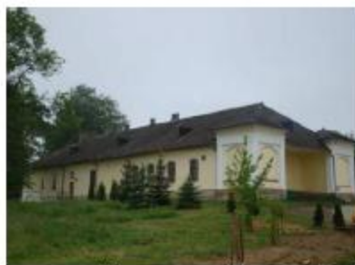
Dwór Stojowskich po remoncie konstrukcji dachowej
