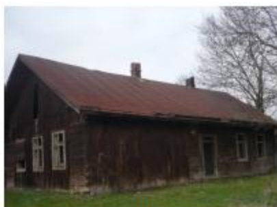
Szkoła Ludowa przed remontem
