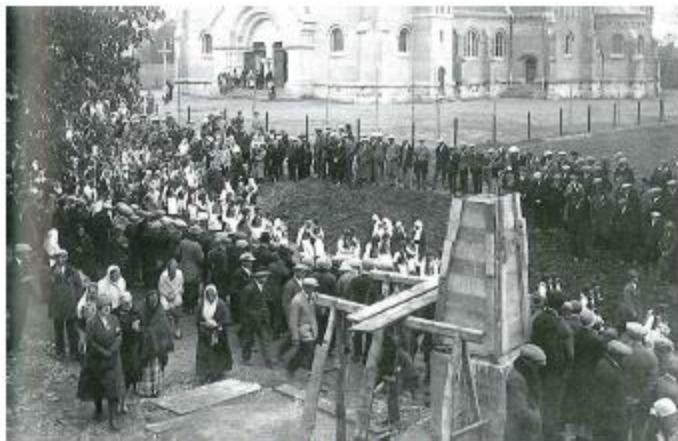
Budowa pomnika rok 1930
