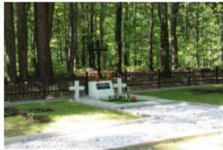
Cmentarz w Jaszczwi po remoncie
