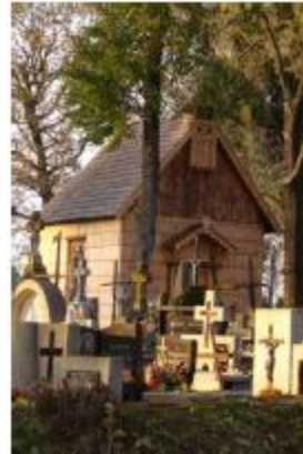
Kaplica po remoncie
