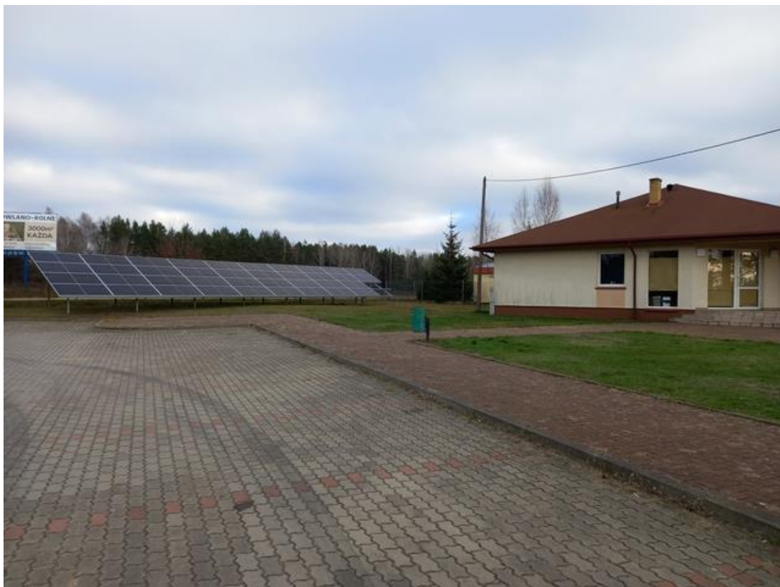
Budynek socjalny przy boisku sportowym w Zarzeczanach
