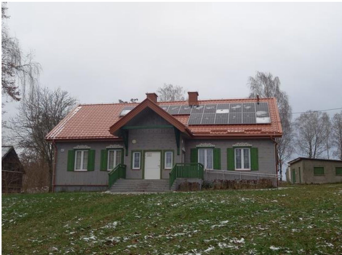
Świetlica wiejska w Wiejkach
