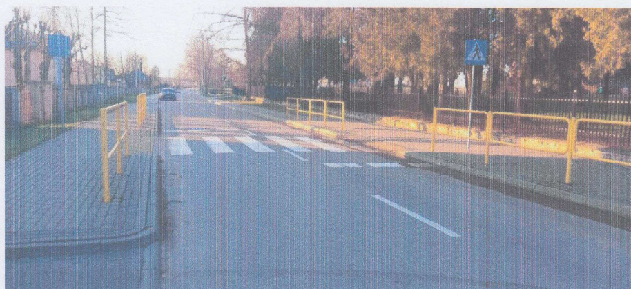
Fotografia 2 . Przejście dla pieszych w ciągu drogi powiatowej nr 1726B przy Zespole Szkół Technicznych ( część ulicy Długiej w Czarajewie ). Ze względu na długie proste odcinki jezdni przed i za przejściem kierowcy często wymuszają pierwszeństwo w stosunku do pieszych oraz przekraczają dopuszczalną prędkość . Kierunek 2
