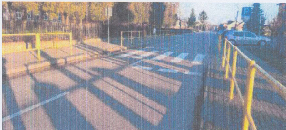
Fotografia 3 . Przejście dla pieszych w ciągu drogi powiatowej nr 1726B przy Zespole Szkół Technicznych ( część ulicy Długiej w Czarajewie ). Ze względu na długie proste odcinki jezdni przed i za przejściem kierowcy często wymuszają pierwszeństwo w stosunku do pieszych oraz przekraczają dopuszczalną prędkość . Kierunek 1
