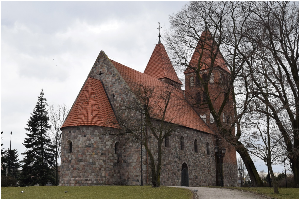
Kościół pw. Imienia Najświętszej Maryi Panny
