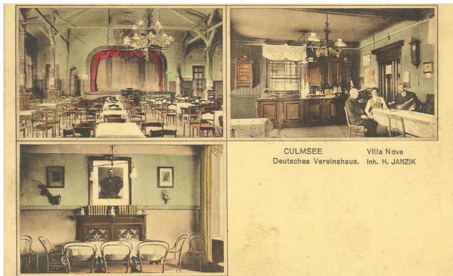
Villa Nova – hotelik wraz z restauracją – widokówka
