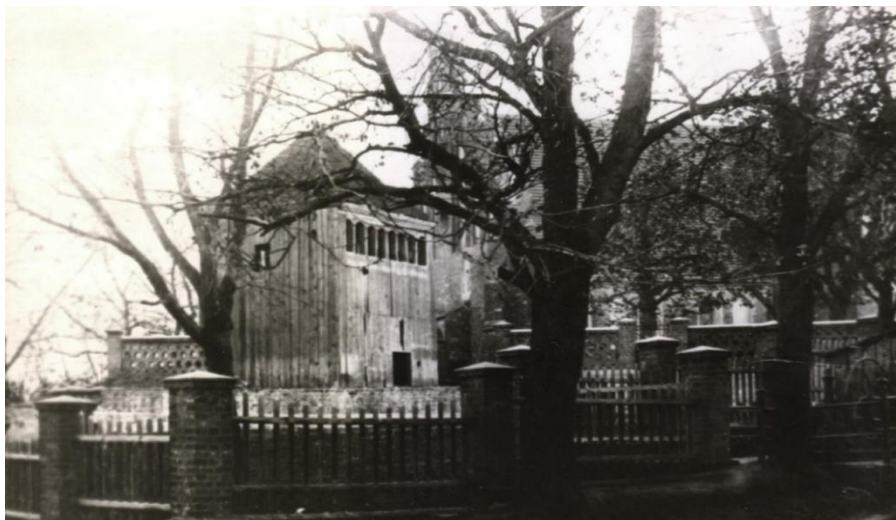
Fot. 8. Stara drewniana dzwonnica przed Kościołem Świętej Trójcy, ze zbiorów MZD
