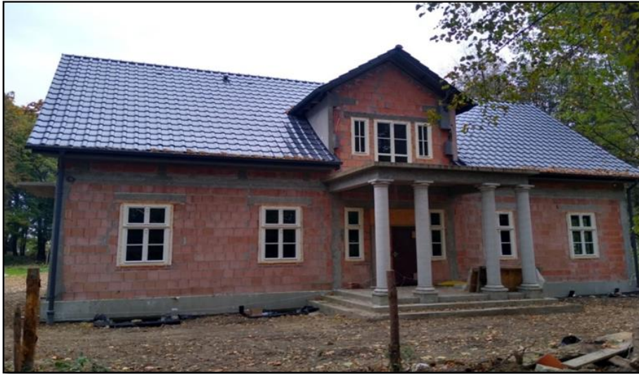
Elewacja frontowa (widok obecny)
