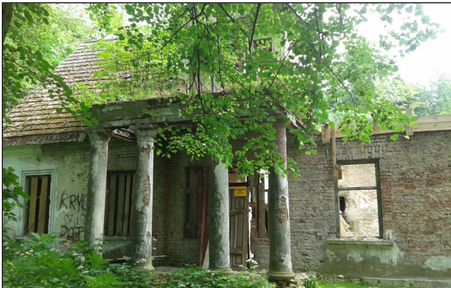
Fragment elewacji frontowej (czerwiec 2017 r.)
