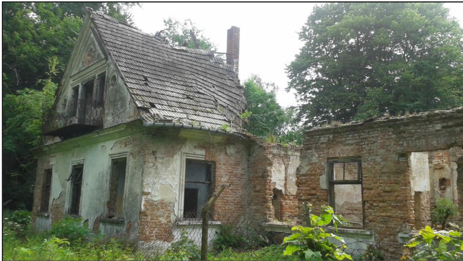
Fragment skrzydła od strony dawnego folwarku (czerwiec 2017 r.)
