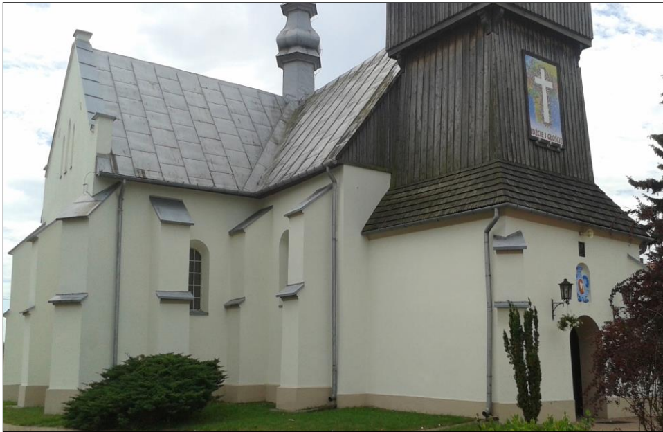
Elewacja od strony półn. - zach.
