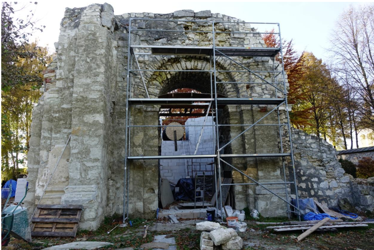
Zdjęcie 14. Odbudowa kaplicy św. Anny - pozostałość po kościele klasztornym w Kątach Starych..
