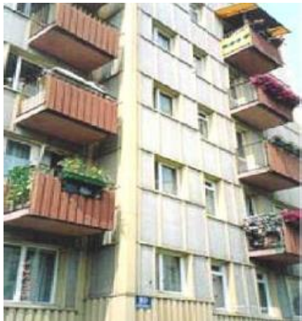
Zdjęcie 10 Elewacja wykonana z płyt azbestowo-cementowych płaskich
