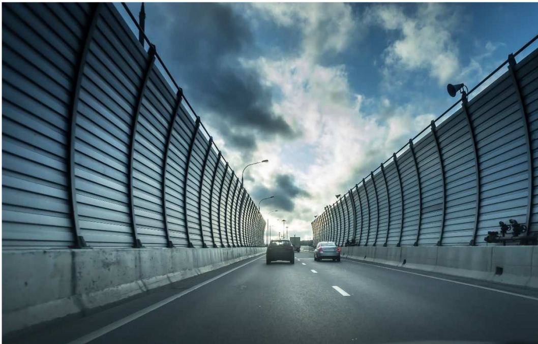
Rysunek 2-19 Ekran akustyczny pozwalający na istotną redukcję hałasu, trudny jednakże do zastosowania w warunkach miejskich.
