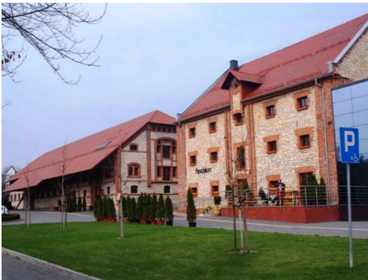
Fot. 3. Olszowa, budynki folwarczne, ul. Hodowlana (fot. materiały Gminy Ujazd).
