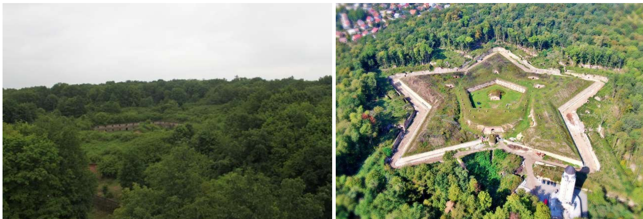
Fort Prusy, Stan fortu w 2017 roku, fot. I. Solisz, oraz stan obecny po wykonanych pracach rewaloryzacyjnych źródło: https://www.facebook.com/401831400197225/photos/a .
