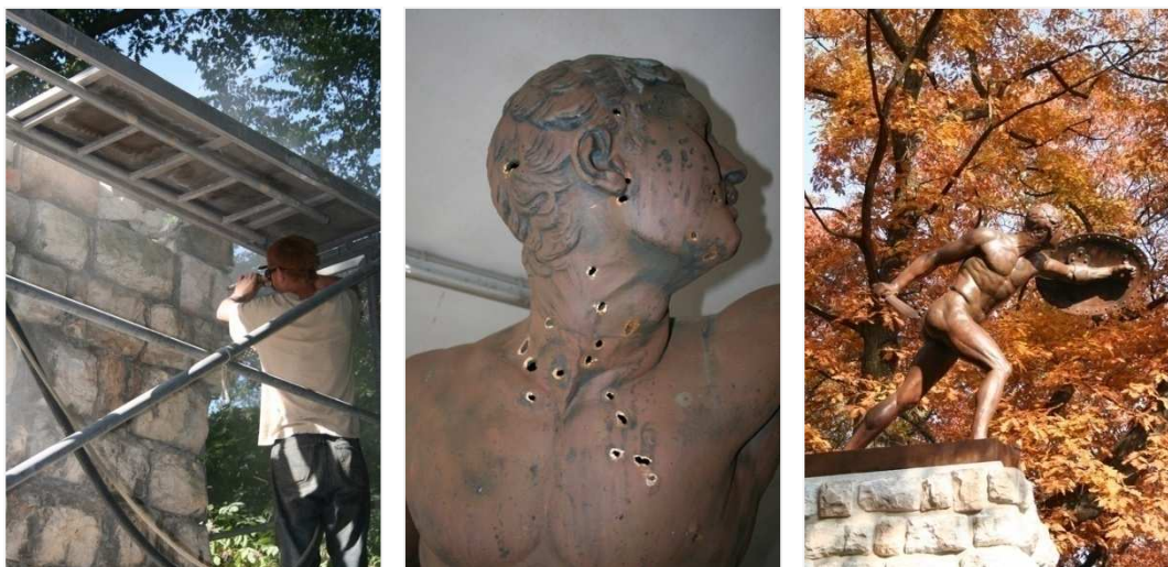
„Brama z Gladiatorami” w trakcie prac konserwatorskich oraz po ich zakończeniu (źródło: www.strzeleccki.pl ).
