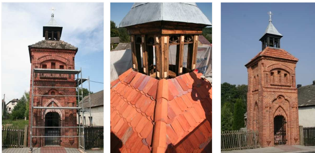
Kapliczka – dzwonnica w Smolarni w trakcie prac konserwatorskich oraz po ich zakończeniu
