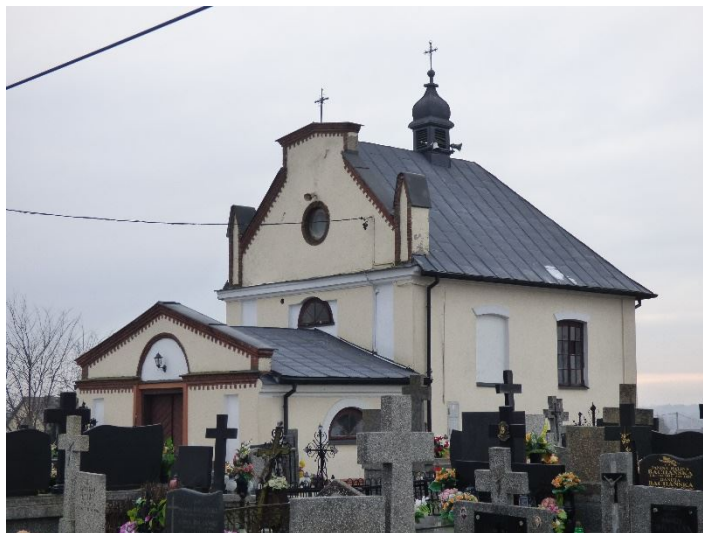
Fot. . Kaplica cmentarna p.w. św. Rocha w Parysowie
