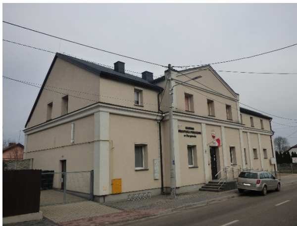
Fot. . Dawna Bożnica, obecnie Gminna Biblioteka Publiczna w Parysowie
