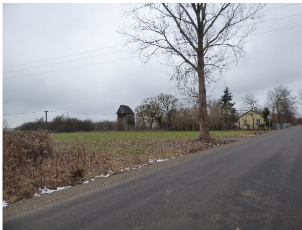
Fot. . Widok na młyn w Parysowie od strony drogi
