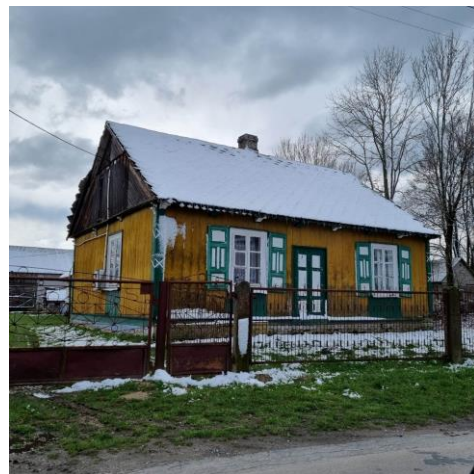
Fotografia 1. Przykład budownictwa drewnianego w miejscowości Jelanka.
