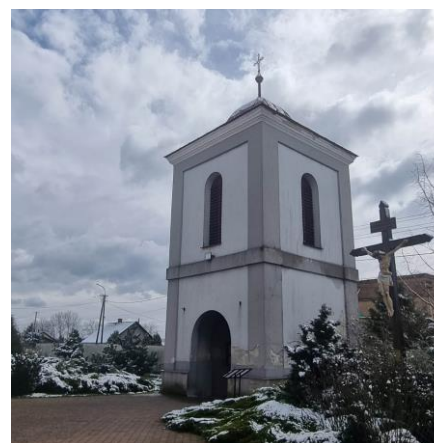
Fotografia 3. Widok na dzwonnice w zespole kościelnym w Rzecznowie.
