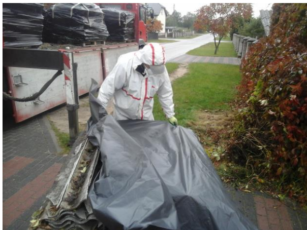
Unieszkodliwienie wyrobów zawierających azbest
