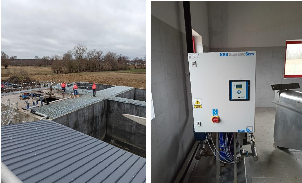
Rozbudowa i przebudowa Gminnej Oczyszczalni Ścieków w Czosnowie
