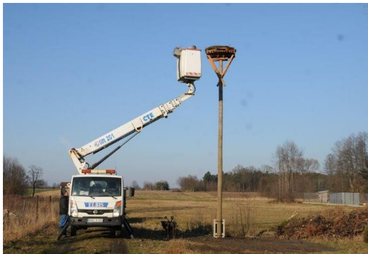
Montaż nowego słupa wraz z platformą i gniazdem bocianim w miejscowości Jadwiniew realizowane przez Regionalną Dyрекcję Ochrony Środowiska w Warszawie
