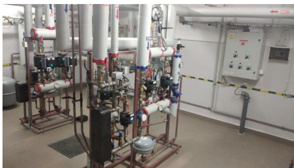
Wymiana węzła cieplnego w budynku KW PSP w Warszawie przy ul. Chłodnej 3
