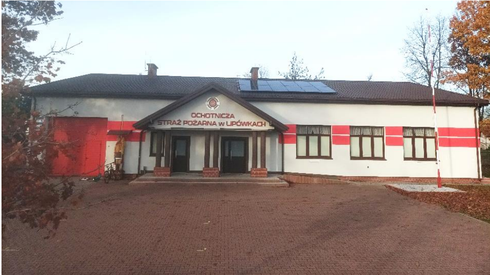
Ochrona powietrza poprzez montaż instalacji fotowoltaicznej w budynku Ochotniczej Straży Pożarnej w Lipówkach
